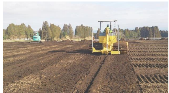
図1 シートパイプの引込み状況
