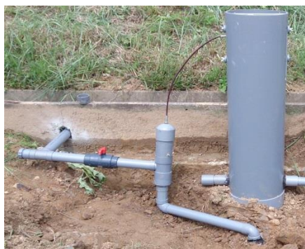
図4 独自開発弁を利用した無電源制御装置
