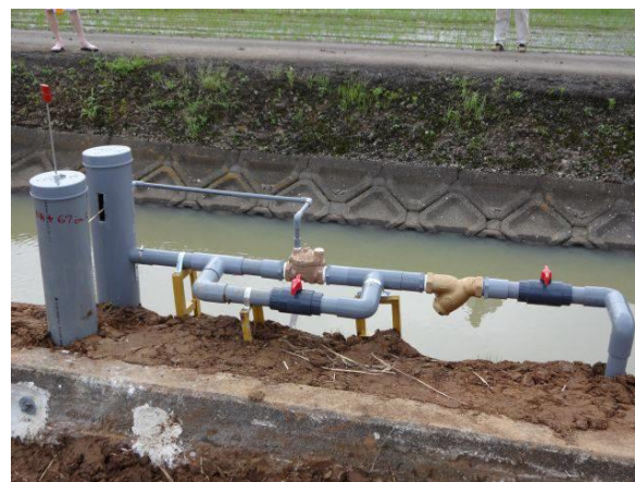
図5 管路用高圧対応無電源制御装置
